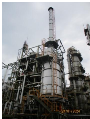
ปล่อง HTS Furnace Off Gas
